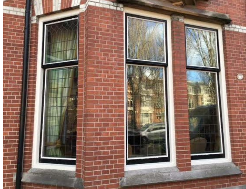
HR + glas (gevuld met krypton) aan de buitenkant. Aan de binnenkant glas in lood teruggezet. Netjes geïntegreerde kozijnen vanwege beschermd stadsgezicht. Foto: Annelies van Ewijk
