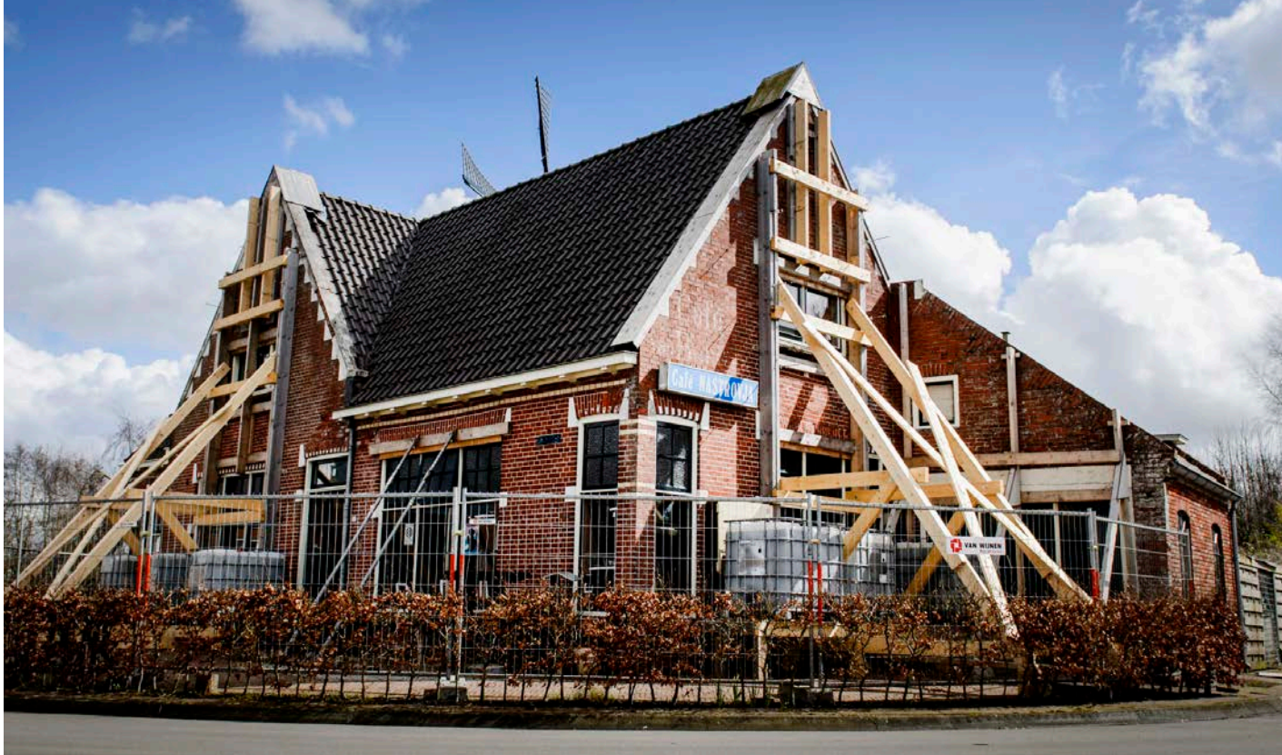
Gaswinningschade. De aardbeving bij Zeerijp op 8 januari 2018 had een kracht van 3,4 op de schaal van Richter en was een van de zwaarste ooit gemeten in de provincie Groningen. Foto: Media.Nu.nl
