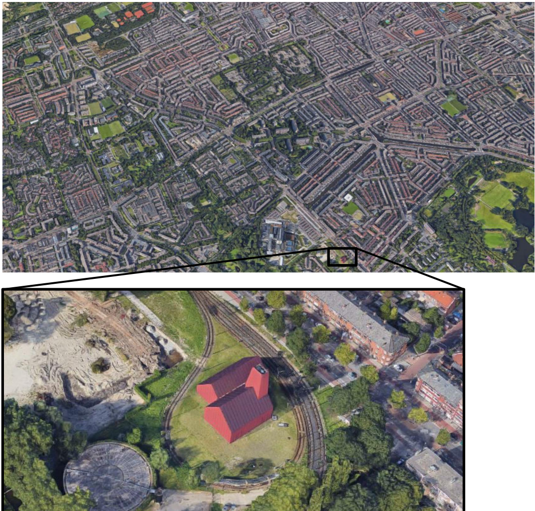
Figuur 4.12 | Locatie Haagse Aardwarmte Leyweg (HAL) ten opzichte van de Vruchtenbuurt in Den Haag. Hemelsbreed ligt de geothermie centrale ongeveer 1.600 m ten zuiden van de Vruchtenbuurt. Het adres van het ketelhuis is Zuidwoldestraat 1 in Den Haag.
